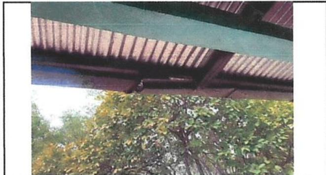
Foto 1: Canales y caídas de agua en mal estado
