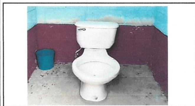
Foto 5: Instalación de servicios sanitarios en mal estado
